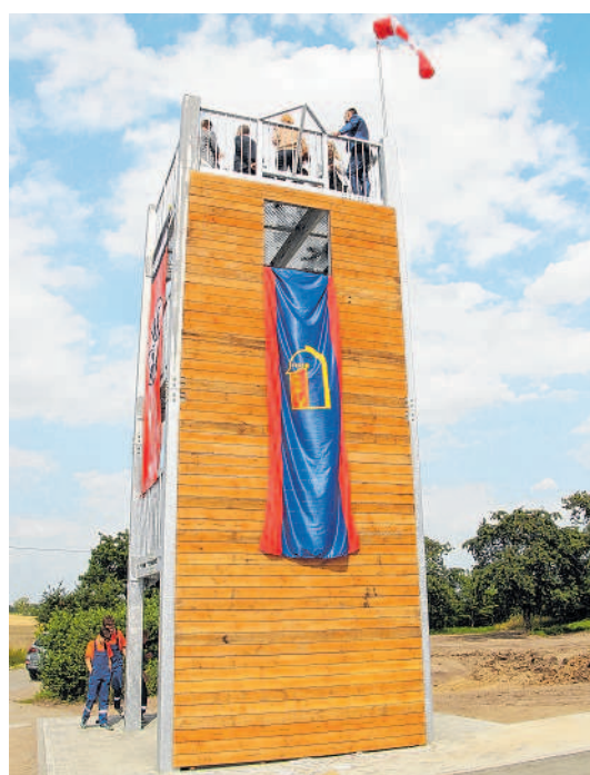
Der 8-Meter-Übungsturm ist ein Teil der Übungsstrecke, die hinter dem Gebäude für das Training in realistischen Einsatzbedingungen eingerichtet wird.
