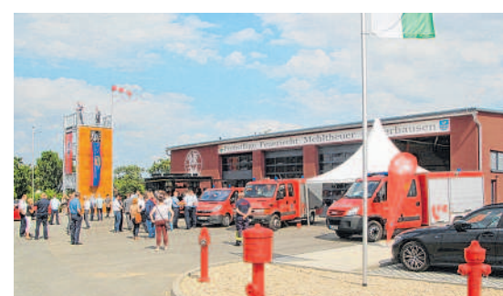
Auf einem weiträumigen und gut erreichbarem Gelände, direkt an der B6 in Mehltteuer ist das neue Feuerwehrgerätehaus entstanden.
