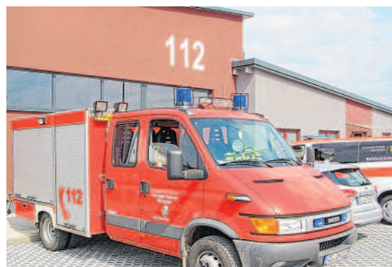
Bei der Fassadenfarbe hatten die Retter ein Wörtchen mitzureden. Es sollte diesmal nicht das klassische Feuerwehr-Rot sein...
